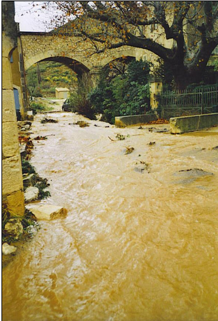
PHOTO 2 : HAMEAU DES CALANS ET VIADUC DU CANAL D'IRRIGATION DURANT LA CRUE DE DECEMBRE 2003
