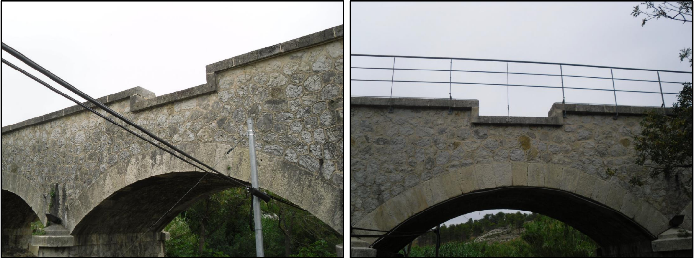
PHOTO 4 : DEVERSOIRS DE SECURITE SUR L'AQUEDUC DE FLANDRIN (COTE AMONT A GAUCHE ET COTE AVAL A DROITE)
