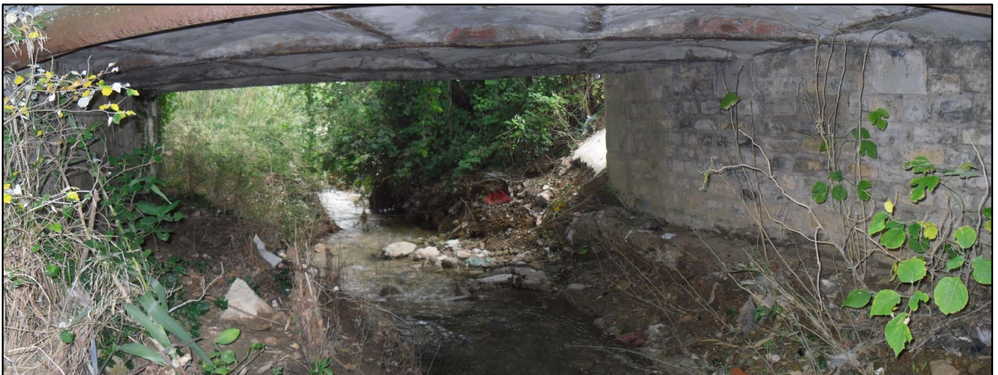
PHOTO 29 : PONT DU CHEMIN DU MAS DE CHABRAN SUR LE GAUDRE DE LA FOUX
