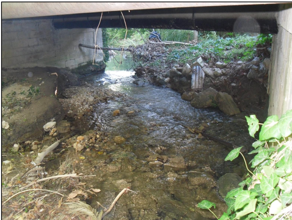
PHOTO 11 : PONT DE LA ROUTE DES BAUX
