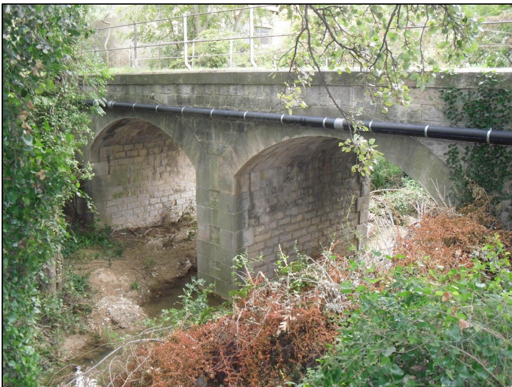
PHOTO 28 : PONT DE L'AVENUE DES ALPILLES SUR LE GAUDRE DE LA FOUX
