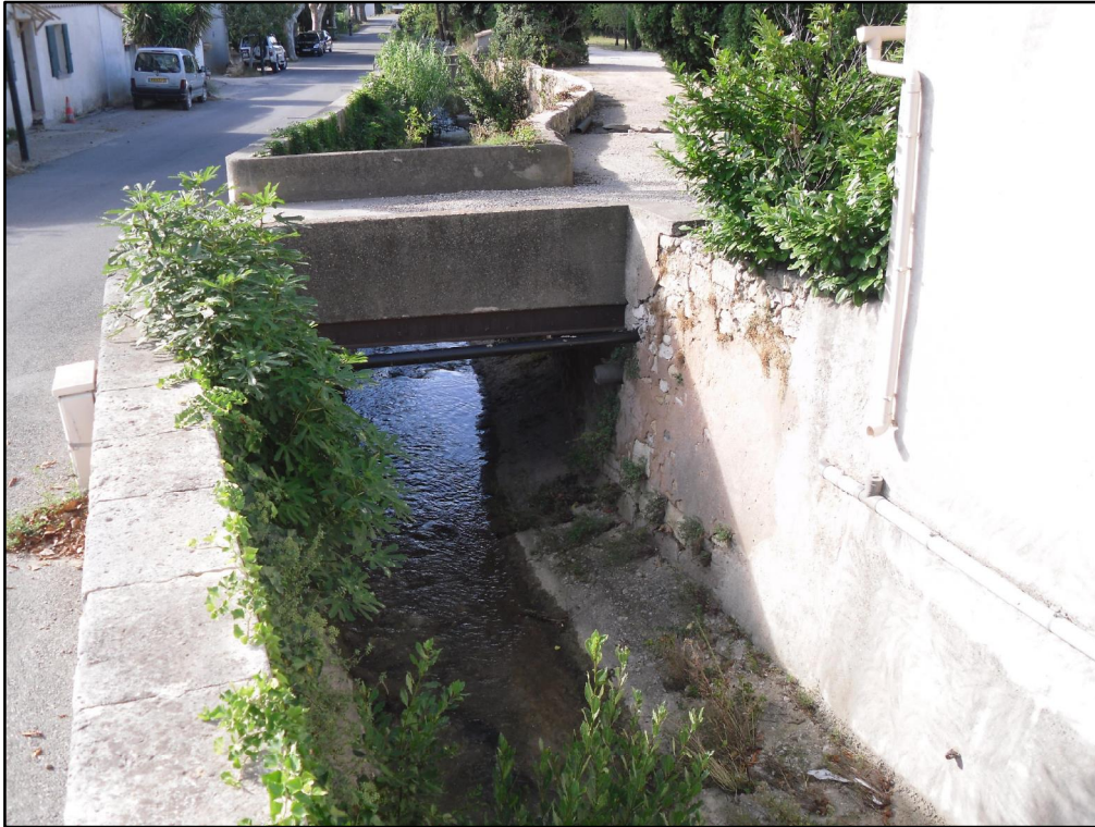
PHOTO 16 : GAUDRE DE LA CROIX EN AVAL DU PONT DE LA RD17
