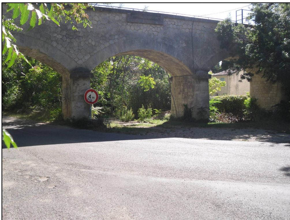
PHOTO 6 : RD27 AU NIVEAU DE L'AQUEDUC DE MANVILLE (CANAL D'IRRIGATION)
