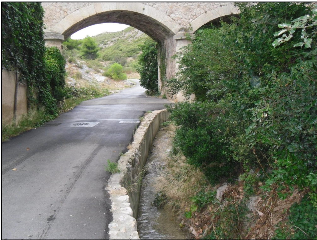
PHOTO 31 : GAUDRE DE VALOSTE EN AVAL DU CANAL D'IRRIGATION
