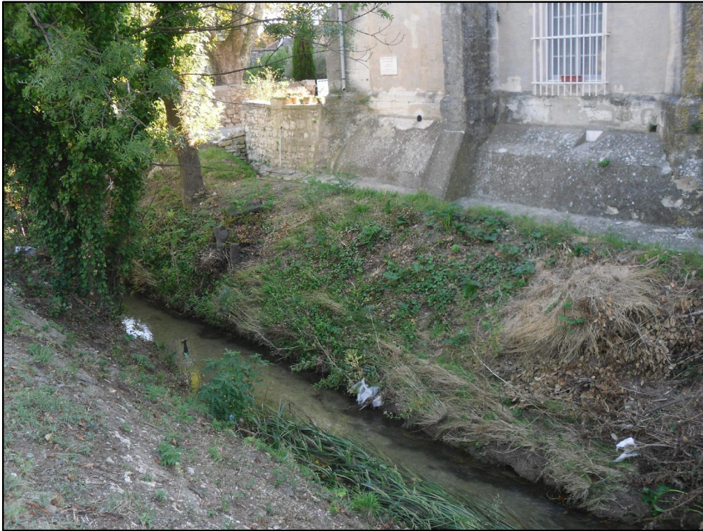
PHOTO 13 : SECTION TRAPEZÉDALE DU GAUDRE EN AVAL DU FRANCHISSEMENT DE L'AVENUE DES ALPILLES
