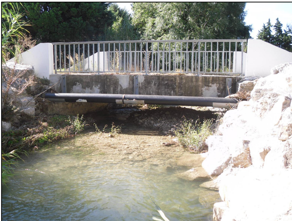
PHOTO 19 : PONT DE LA RD17C SUR LE GAUDRE DE LA CROIX
