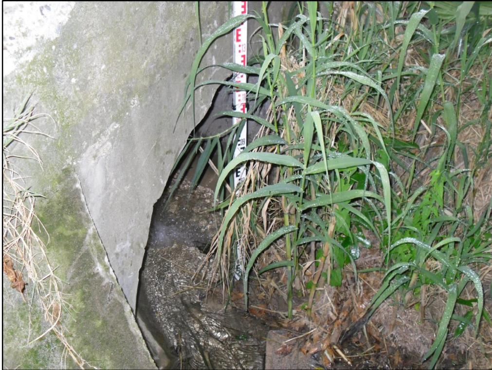
PHOTO 33 : BUSE 1200 MM AU DROIT DE LA RD78
