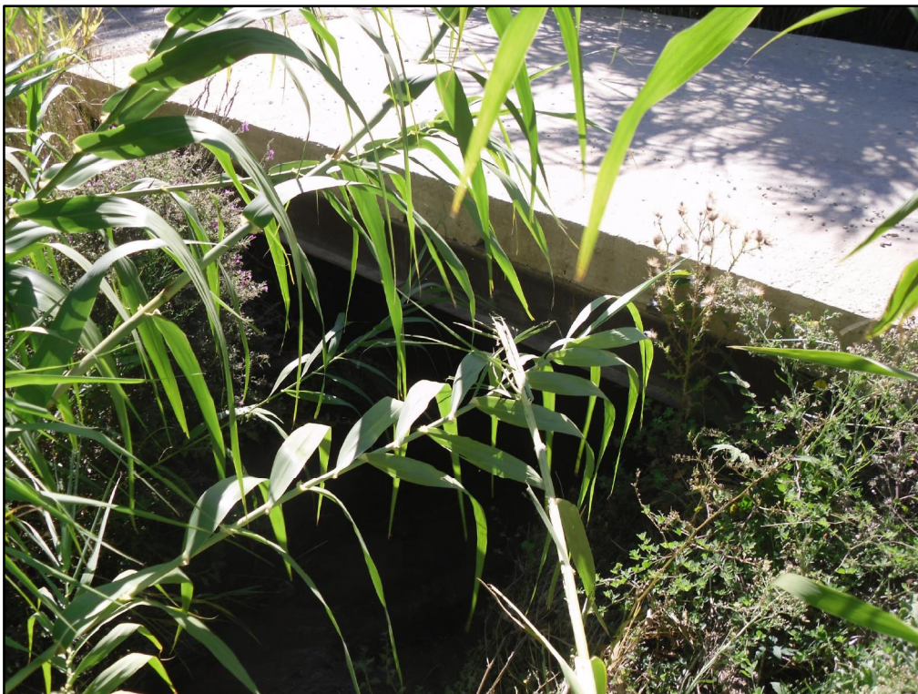
PHOTO 22 : PONT CADRE PERMETTANT L'ACCES A UNE HABITATION
