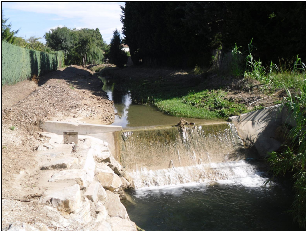
PHOTO 18 : SEUIL EN AMONT DU FRANCHISSEMENT DE LA RD17C
