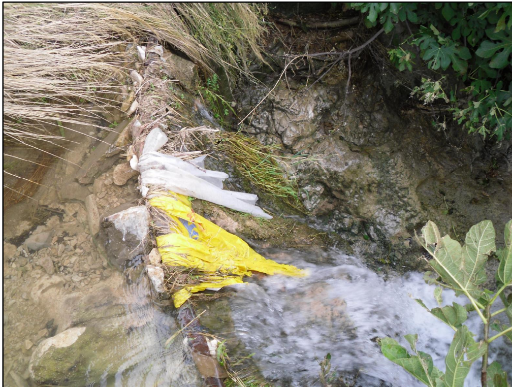
PHOTO 24 : SEUIL NATUREL AU DROIT DU CANAL D'IRRIGATION
