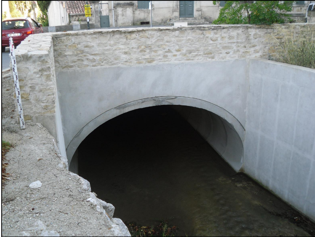
PHOTO 15 : PONT DE LA RD17 SUR LE GAUDRE DE LA CROIX
